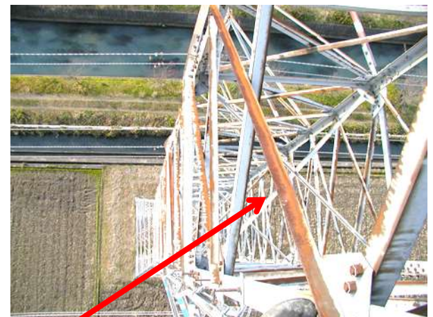
154kV鉄塔(塔上から撮影)
