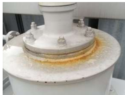
【油密部漏油状況】
