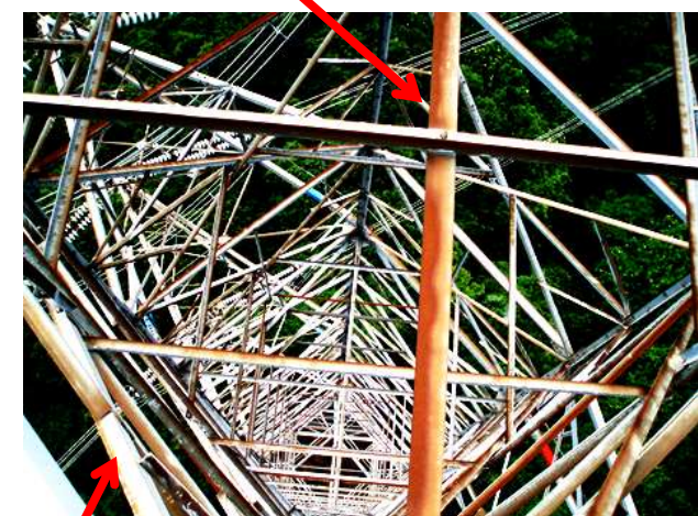
500kV鉄塔(塔上から撮影)
