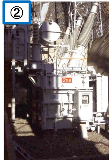
<発電用変圧器>
