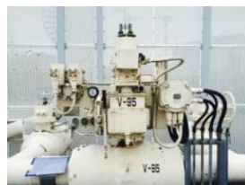
バルブ駆動機 (高圧・中圧)
