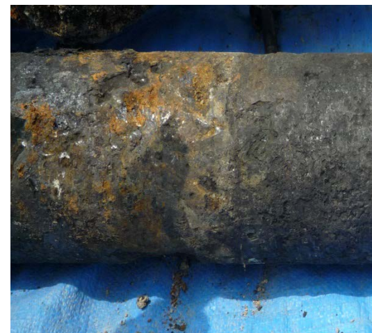
腐食したDG管
