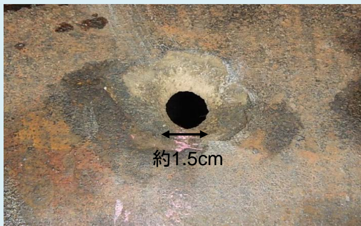
図2. 腐食孔の状況
