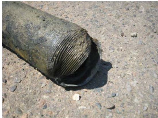
地震被害を受けたねじ接合管（白ガス管）
