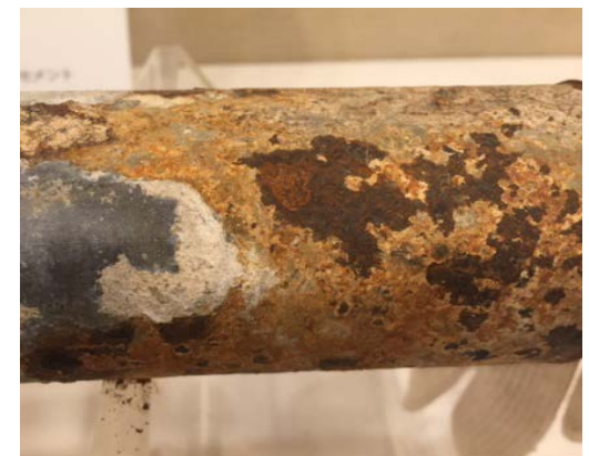
腐食したねじ接合管（白ガス管）
