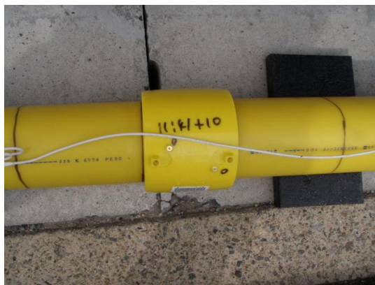
直管と継手の融着接合状況
