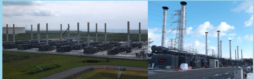
苫小牧発電所2号機～83号機 出力:7.4万kW
