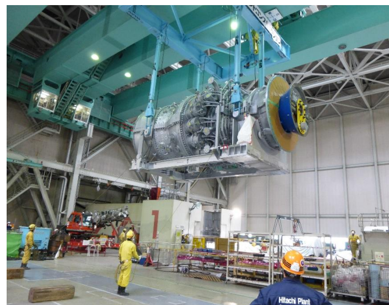
ガスタービンの据付
