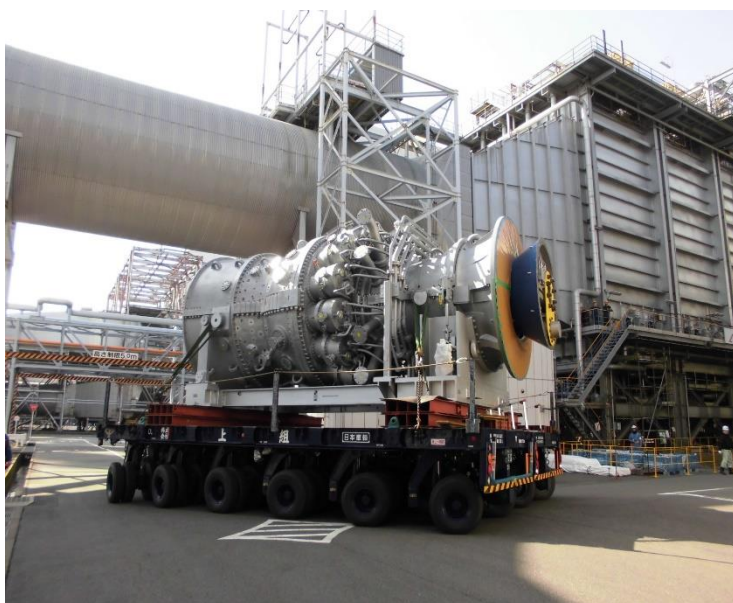
ガスタービンの発電所構内輸送
