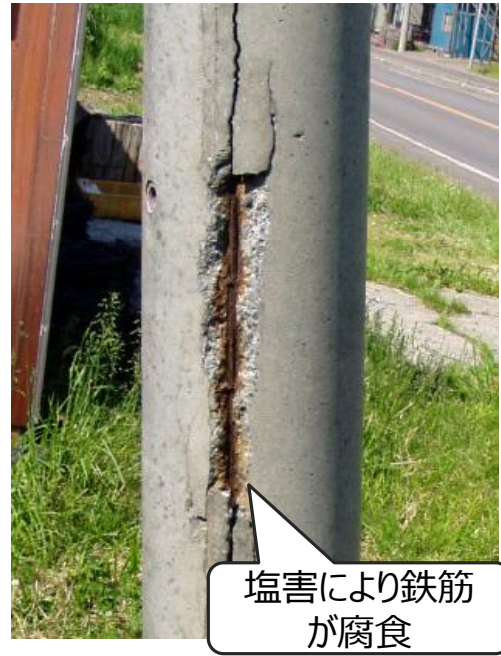
<塩害による劣化状況>
