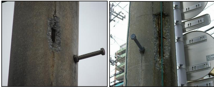
図1.コンクリート柱の表面剥離状況
