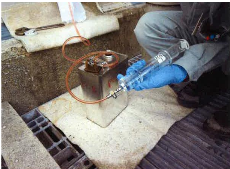
油中ガス分析（変圧器からの採油作業）
