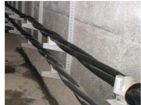
写真：地中ケーブル
