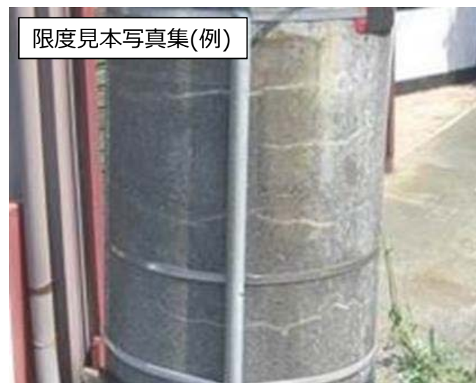
写真：横方向に長く細いひびが発生している電柱 ※「建替要」⇒「状態監視」に見直し
