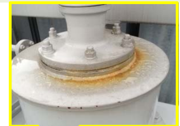
写真：油密部からの漏油
