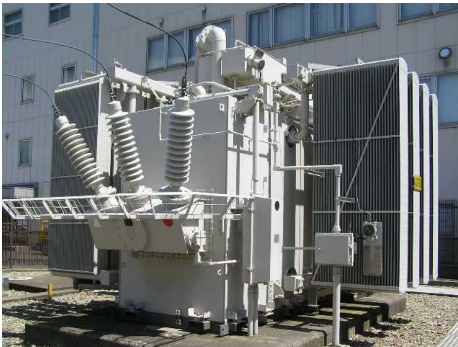
[6万ボルト変圧器] (外観)
