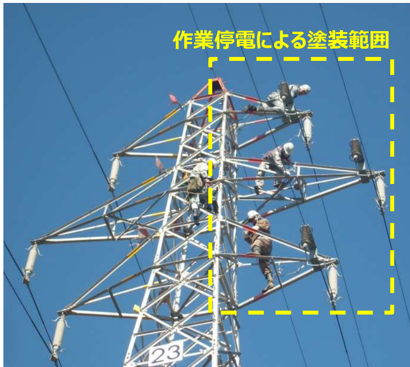
〈鉄塔塗装作業〉
