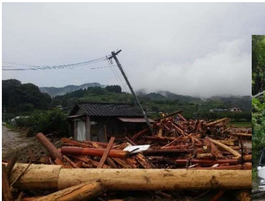
流倒木による配電線被害
