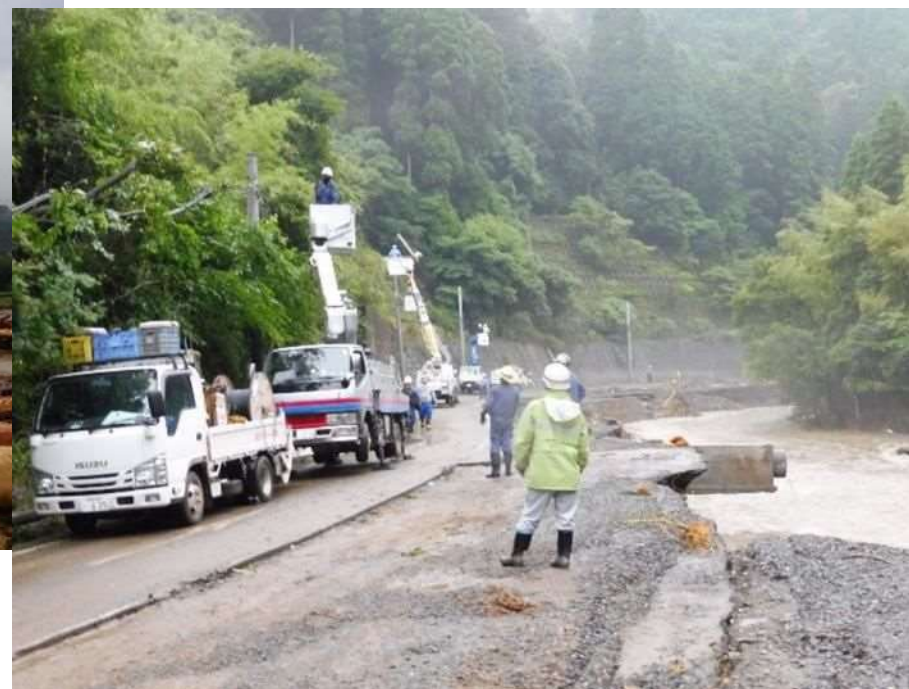
配電線被害の復旧作業
