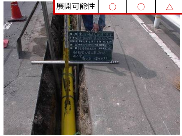
導管敷設工事
