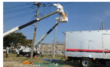
四国電力送配電の電源車による 応急送電
