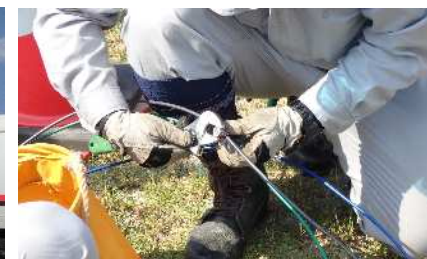
四国電力送配電の資材による 低圧引込線断線修理
