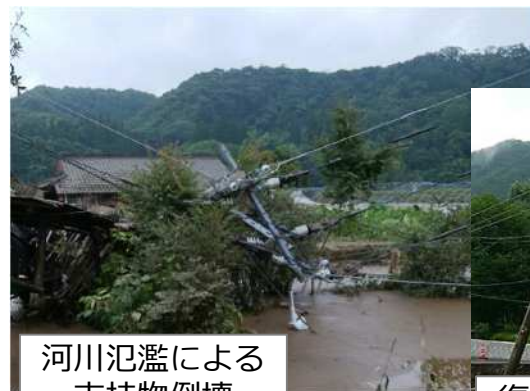
倒木による断線・ 支持物折損
