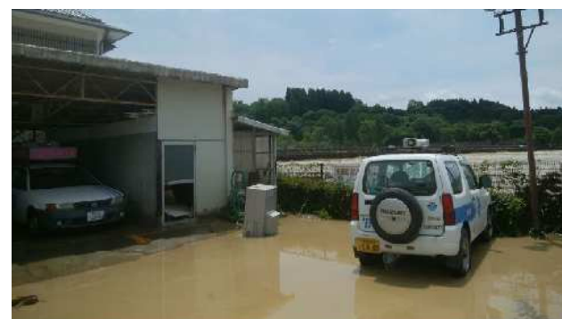
球磨川氾濫後の 人吉配電事業所駐車場
