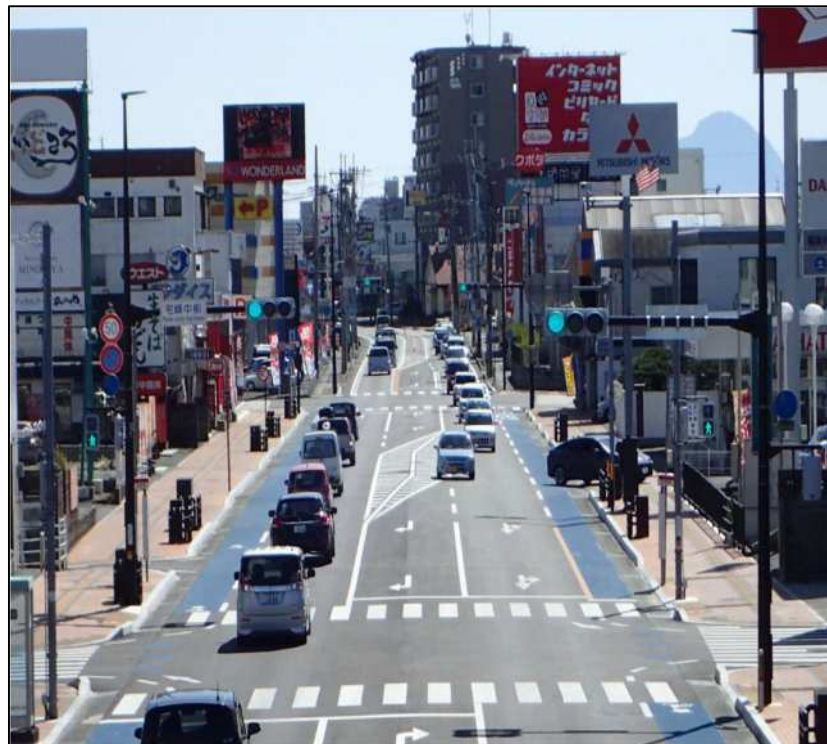
無電柱化工事の推進
