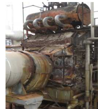
屋外高経年化設備（排ガス熱回収装置）
