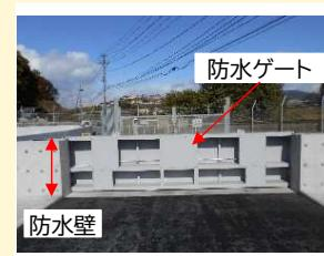
防水壁・防水ゲートの設置による変電所浸水対策
