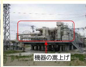
機器の嵩上げによる変電機器の冠水対策
