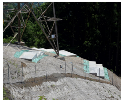
鉄塔周辺斜面への抑止杭設置例
