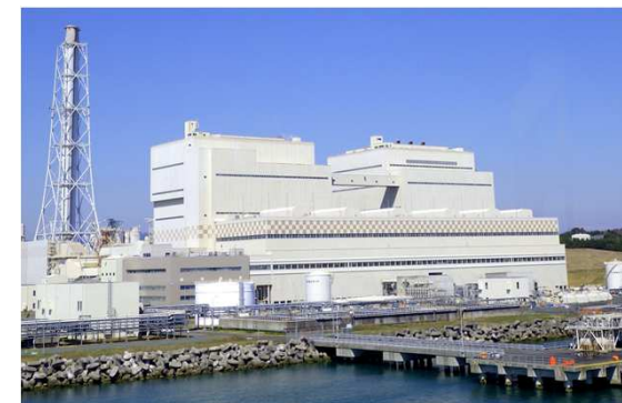
原町火力発電所
