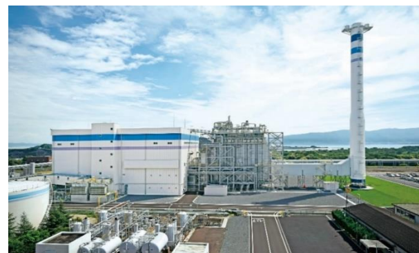
坂出發電所新2号機
