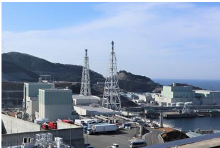
島根原子力発電所
