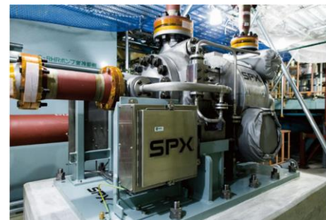
高圧原子炉代替注水ポンプの設置
