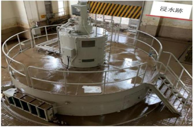
② 夏井川第三発電所 取水口自動制御盤冠水状況
