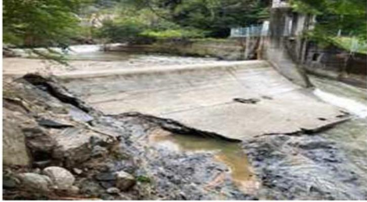
④ 上田発電所 取水口等関連機器損傷（流木堆積）状況
