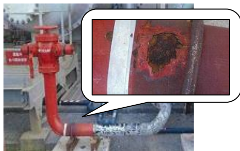
消火設備補修
