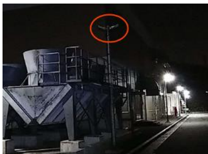
構内照明設備補修
