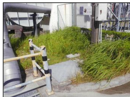
※保全作業前の状況
