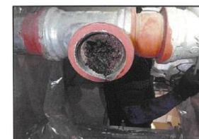
給湯用配管補修
