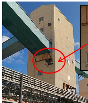
連絡建屋補修
