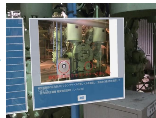
設備に近づく、自動で確認ポイントや注意事項等のデジタルコンテンツを表示
