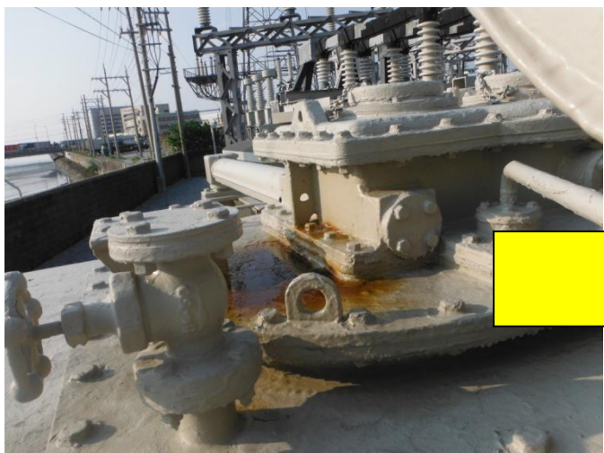
(平成25年)変圧器本体錆腐食漏油
