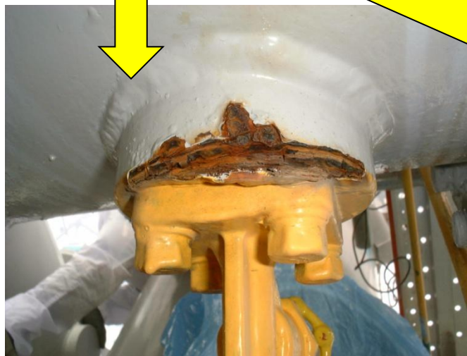
GISガス配管接続部錆腐食部分(拡大)
