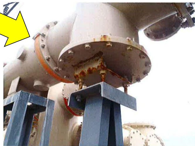
GIS母線下部錆腐食部分
