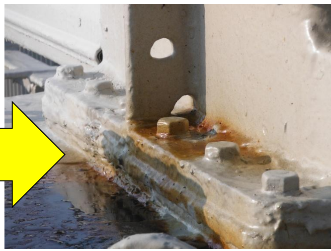
(平成25年)変圧器本体錆腐食漏油(拡大)
