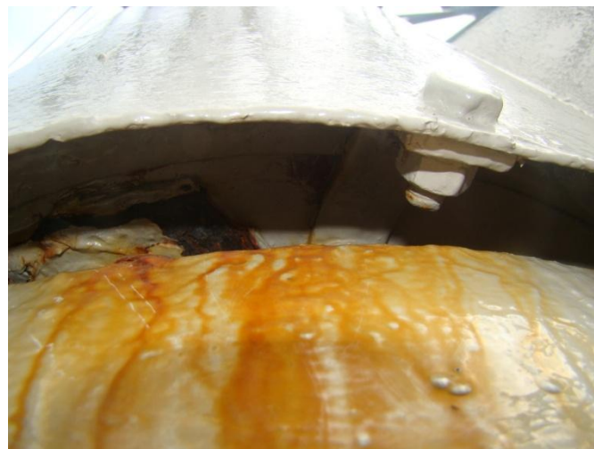
GIS変流器カバー下錆腐食
