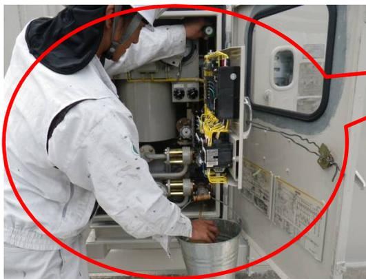
測定試験(絶縁抵抗測定)
