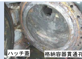
X-6ペネハッチの開放後の状況
