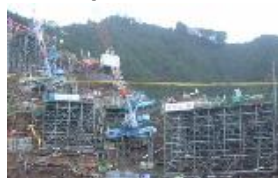
<作業構台設置>
