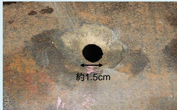
図2. 腐食孔の状況
