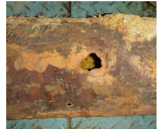
腐食したGM管
