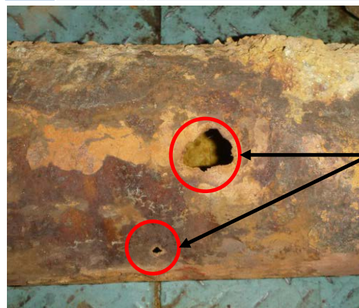
図1. 腐食したGM管
