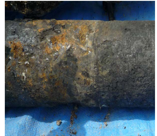
腐食したDG管
