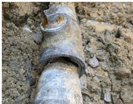
ねじ接合管(白ガス管)
