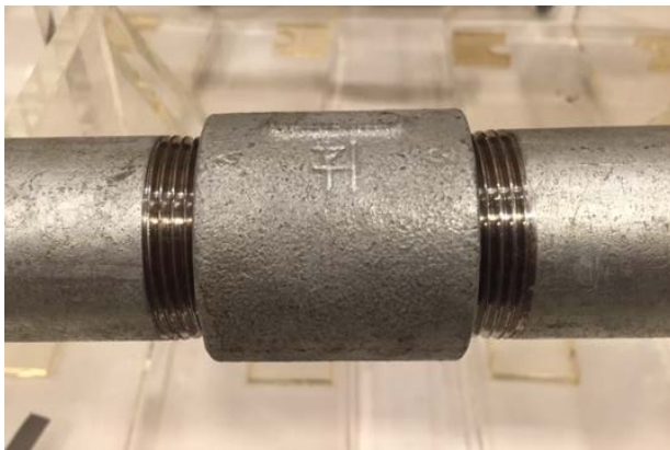
ねじ接合管（白ガス管）の接合部
