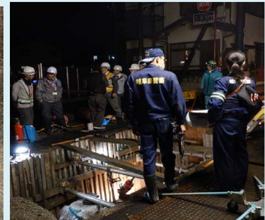
図3. 現場状況(警察による現場検証)
