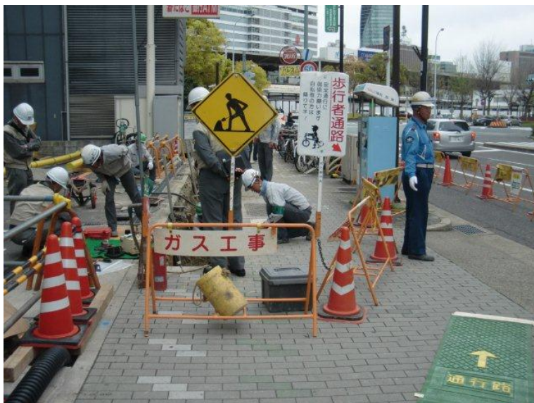
入替工事現場風景
