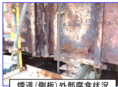
煙道（側板）外部腐食状況
