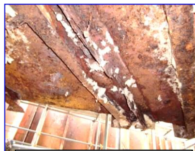
煙道（底板）外部腐食状況
