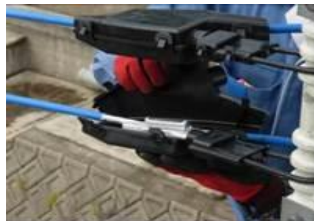
[アルミ電線の支持工法検証]
