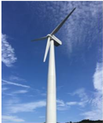
風力発電設備
