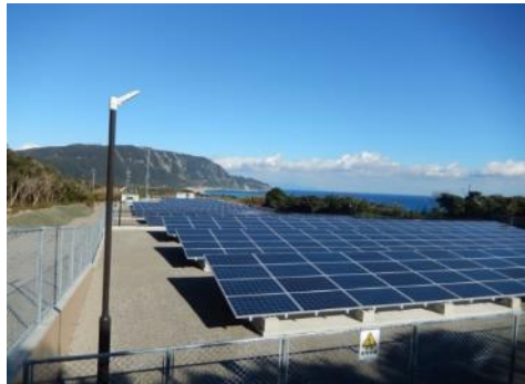
太陽光発電設備
