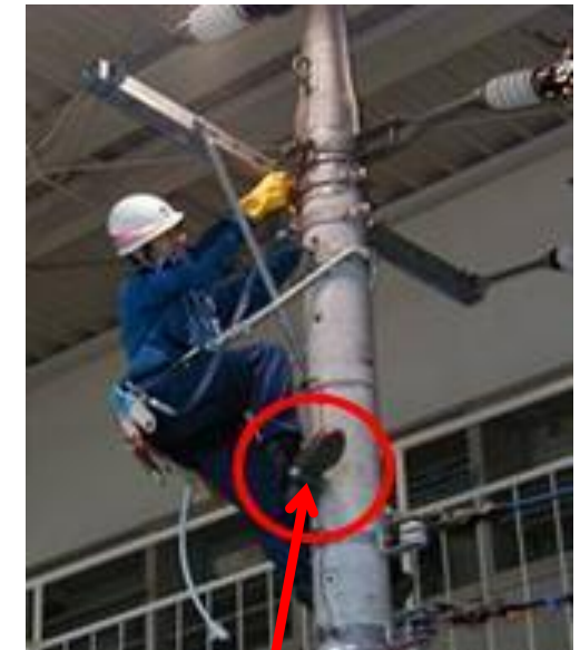
電柱の足場ボルト
