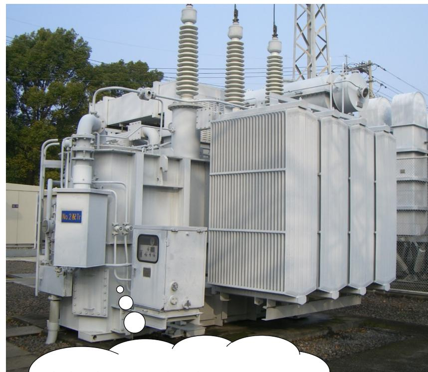
巻線は変圧器の内部にあるため、絶縁油中の劣化生成物濃度から巻線の絶縁紙の強度を推定
