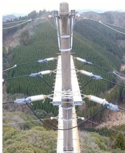
巡視が困難な山間部の 配電線巡視状況
