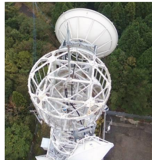
通信無線鉄塔の巡視状況
