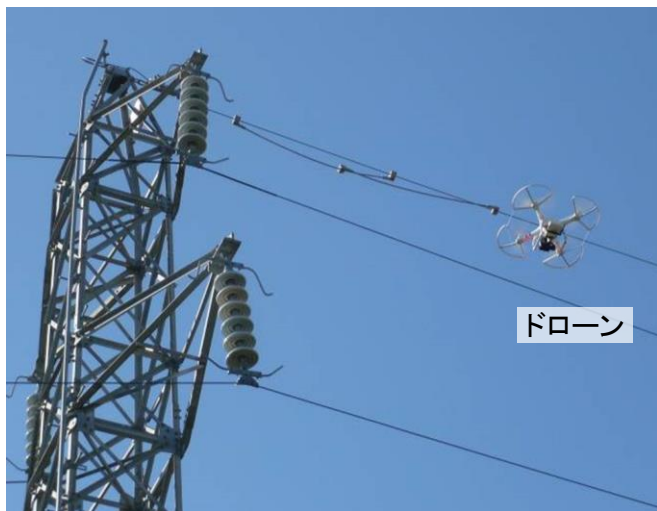
送電線の設備確認状況
