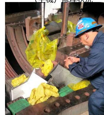
写真：火力発電所がタービン（主機）修理状況
