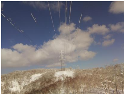
着雪監視状況
