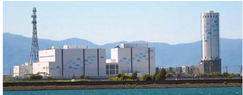
石狩湾新港発電所1号機（56.94万kW）
