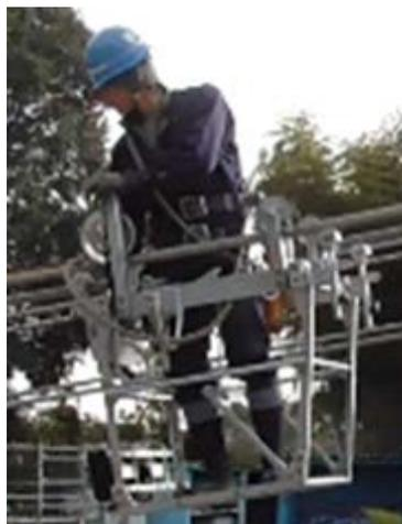
電動アシスト付き宙乗機とすることで、安全性の向上、電線上の移動時間の短縮および作業員の負担を軽減
