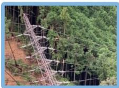
資料提供：中部電力パワーグリッド株式会社
