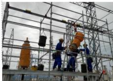
接続箱組み立て
