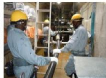
ケーブル布設
