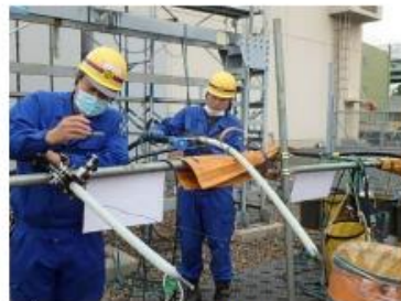
ケーブル削り
