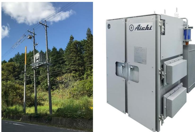
柱上に、右の写真のような無効電力補償装置が設置され、送配電ネットワークの電圧が過度に低下しないようにしている。
