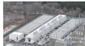
東北電力 西仙台変電所 40MW-20MWh
