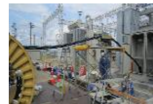
<電力ケーブル工事>
