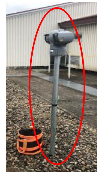
構内に自立させ設置
