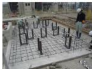
<ベース据付・配筋>
