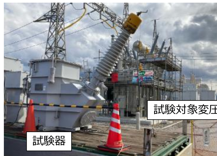
試験器を用いた現地耐圧試験
