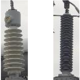
磁器碍管（左）とポリマー碍管（右）
