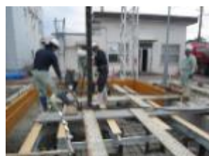
<コンクリート打設>
