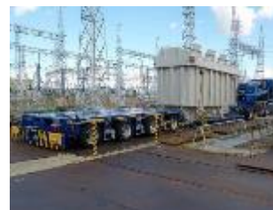
<変圧器運搬・搬入>
