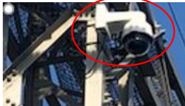
変電所屋外鉄構に取付
