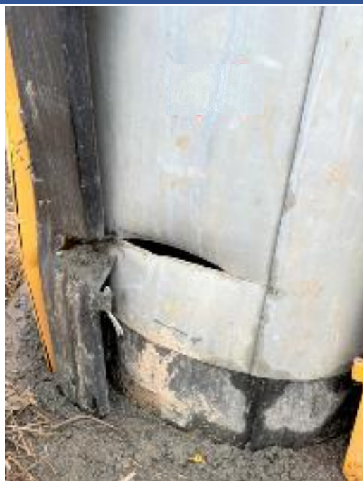
農耕機器接触による損傷事例
