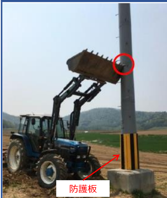
農耕機器接触による損傷事例
