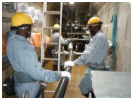
ケーブル布設
