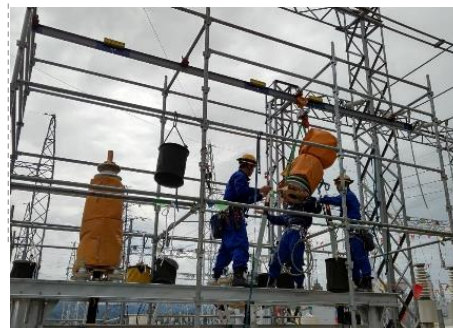
接続箱組み立て
