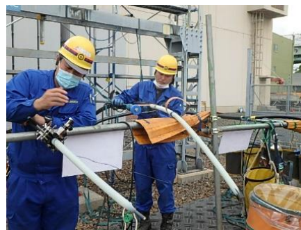
ケーブル削り
