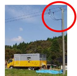
電圧・電流センサーの無線化により、必要となる工事用開閉器や接続ケーブルを削減
