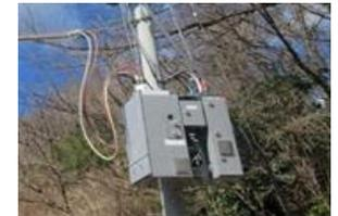
軽量コンパクト化したことにより、地上に設置していたものを電柱上に設置を実現
