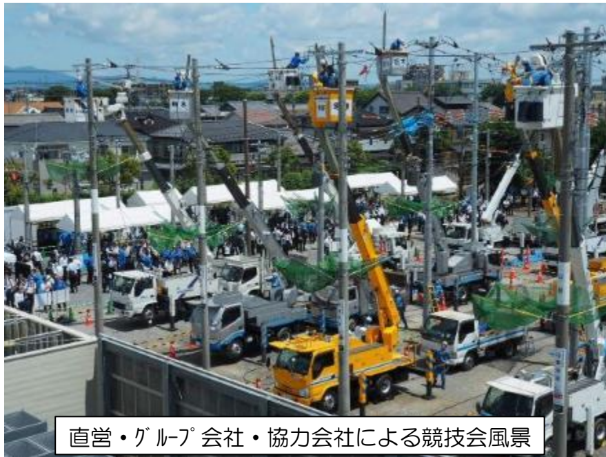
架空配電工事
