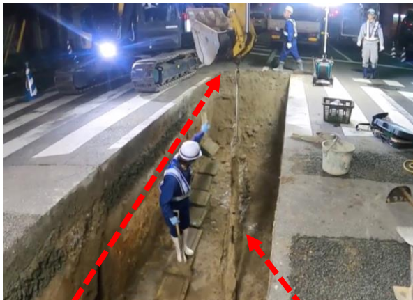
〔既設管路撤去〕
