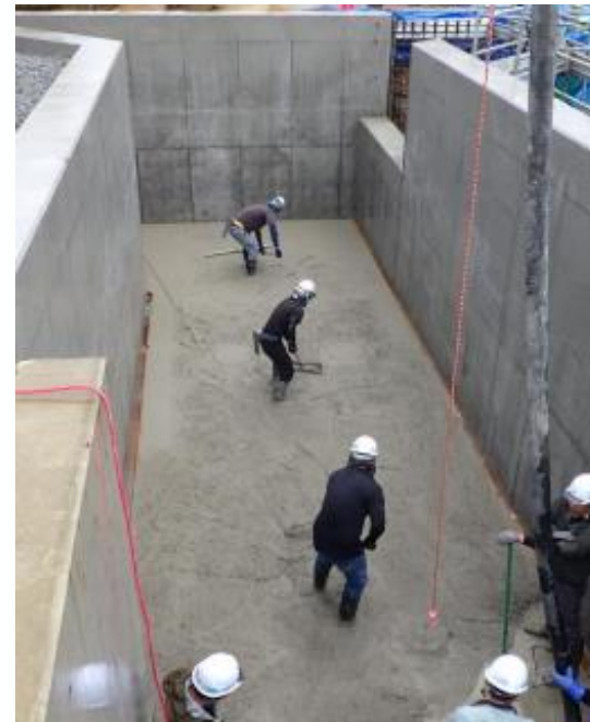
＜現場打ち洞道の例＞
